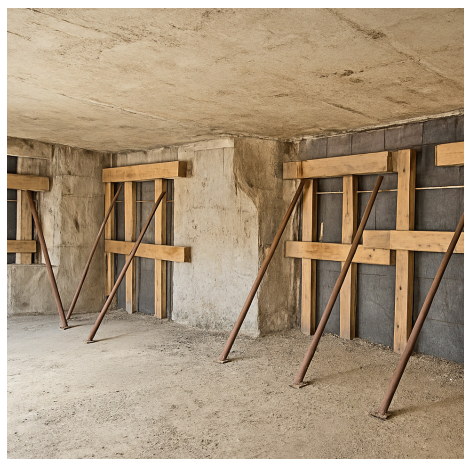
Murs étanchés et étayés
